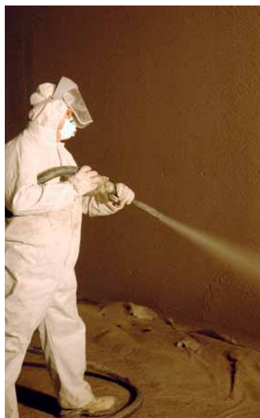
Polier Ingo Hermann beim Auftragen des Feinbetons mit Edelstahlfasern. Foto: Flint
