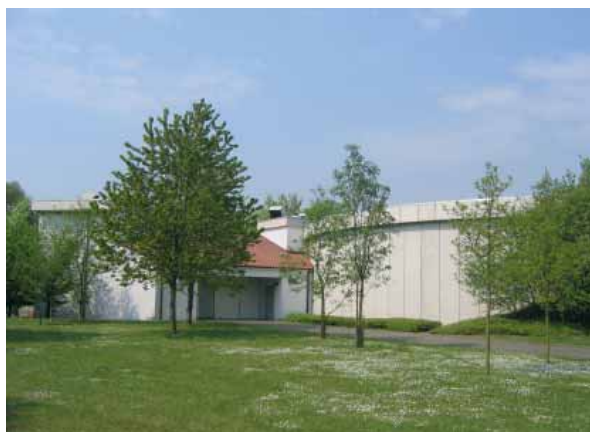
Der 5000 m 3 Tagesspeicher Hedem im Kreis Herford trägt einen wichtigen Teil dazu bei, die Wasserversorgung in der flachen, wasserarmen Region zu sichern. Foto: WBV
