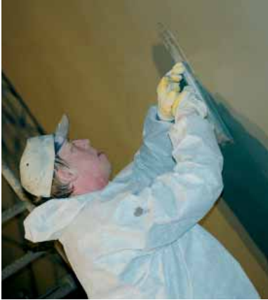
Flint Facharbeiter beim Glätten der Oberfläche. Foto: Corinna Scholz
