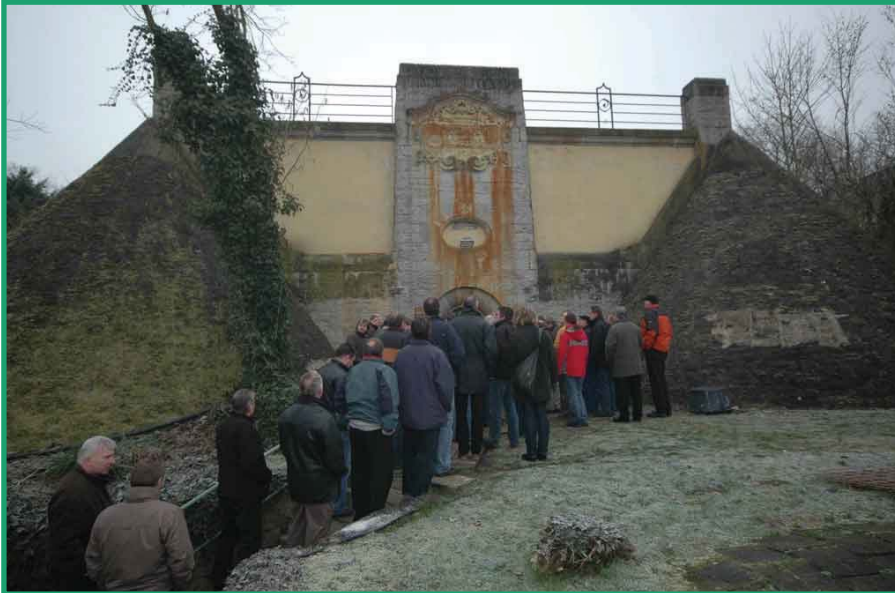
1. Durch ein imposantes Portal aus der Gründerzeit gelangten die Teilnehmer in den Behälter.
