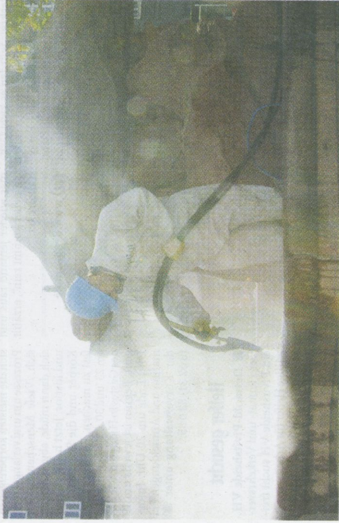
Wassermobel im Gegenlicht: Uwe Dubbert rückt dem Donop-Brunnen mit einem Wirbelstrahl-feinsten Glasmehls auf die Pelle
