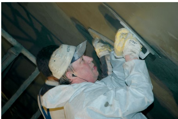
Zwei Facharbeiter beim Glättungsvorgang, um eine absolut ebene Oberfläche zu erreichen.
