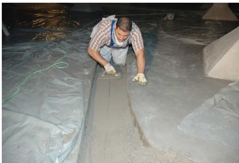
Im Behälter Hüllberg arbeitet A. Ouchani die Ablaufrinne aus. Foto: Flint
