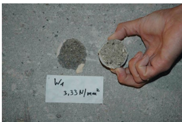
Ermittlung der Haftzugfestigkeit Wasser berührender Oberflächen. Foto: Flint
