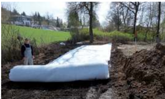
Abb. 5: Über dem Behälter brachte das Sanierungsteam ein Geovlies (Faserschicht) ein, um eine Beschädigung durch Wurzeln zu verhindern.
