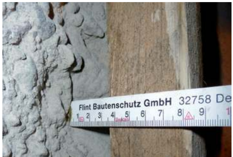
Abb. 3: Nach Abtragen der alten Beschichtung zeigte sich ein Untergrund mit flächig verteilten Lunkern sowie unzureichender Haftzugfestigkeit, um die neue mineralische Auskleidung direkt aufbringen zu können.
