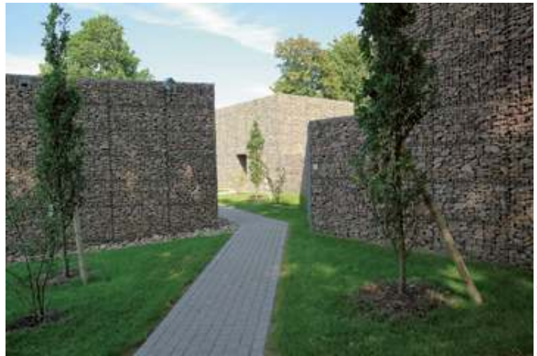
Abb. 2: Die mit Steinen gefüllten Drahtkörbe dienen als Außenverkleidung der Wasserbehälter.
