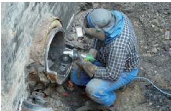
Abb. 4: Die alten Rohrleitungen aus Stahl wurden entfernt bzw. gekappt und als Wanddurchführung für die neuen Edelstahlrohre verwendet.
