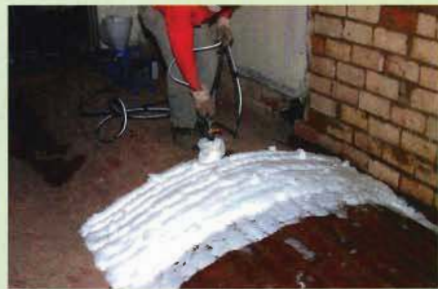
Abb. 4: Mit geprüften und zugelassenen Schwammsperrmitteln wird die Kappendecke behandelt.
