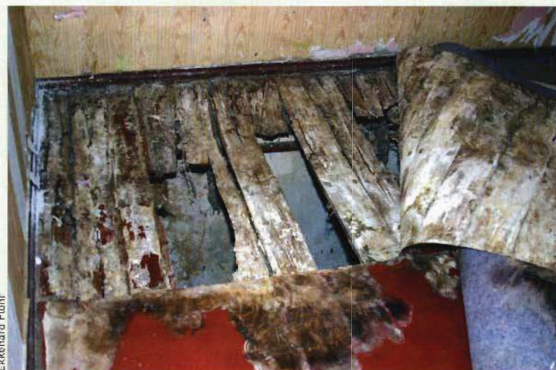
Abb. 3: Der Echte Holzschwamm hat eine Holzbalkendecke komplett zerstört. Es besteht Einsturzgefahr.
