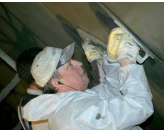
Abb. 5: Facharbeiter beim Glättungsvorgang, um eine absolut glatte Oberfläche zu erreichen
